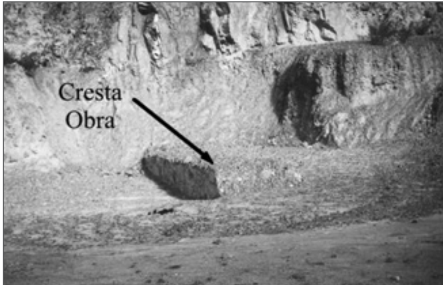
Figura 13. Situación del lecho en correspondencia con una presa construida en el río Colanzulí-Iruya
