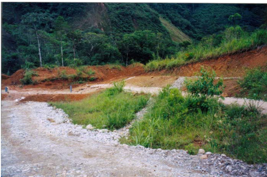
Fotografía 2: Relleno Sanitario de Zamora
