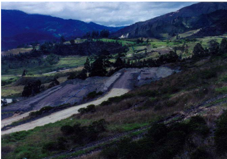
Fotografía 3: Relleno sanitario manual de los desechos biopeligrosos en Loja
