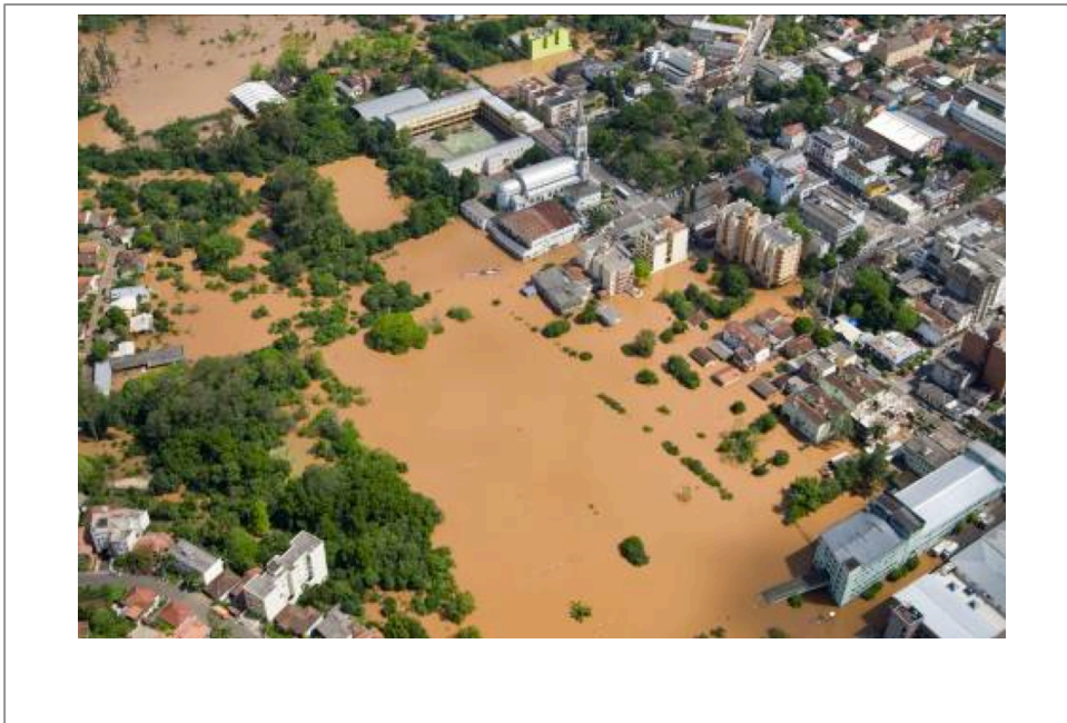
Figura 4. Inundación en el Arroyo do Engenho – Lajeado. Fuente: AHSUL (2012) Figure 4. Flooding in the do Engenho Stream – Lajeado. Source: AHSUL (2012)
