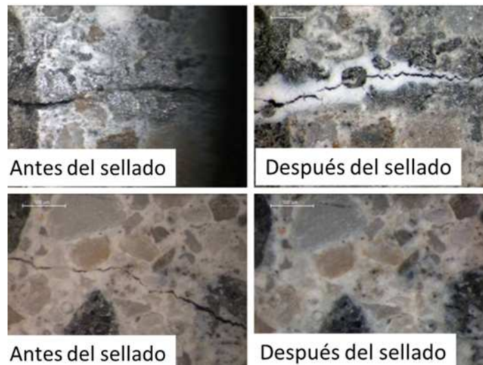
Imagen 4. Imagen en microscopio óptico convencional de sellado de la fisura en una superficie de una probeta de hormigón
