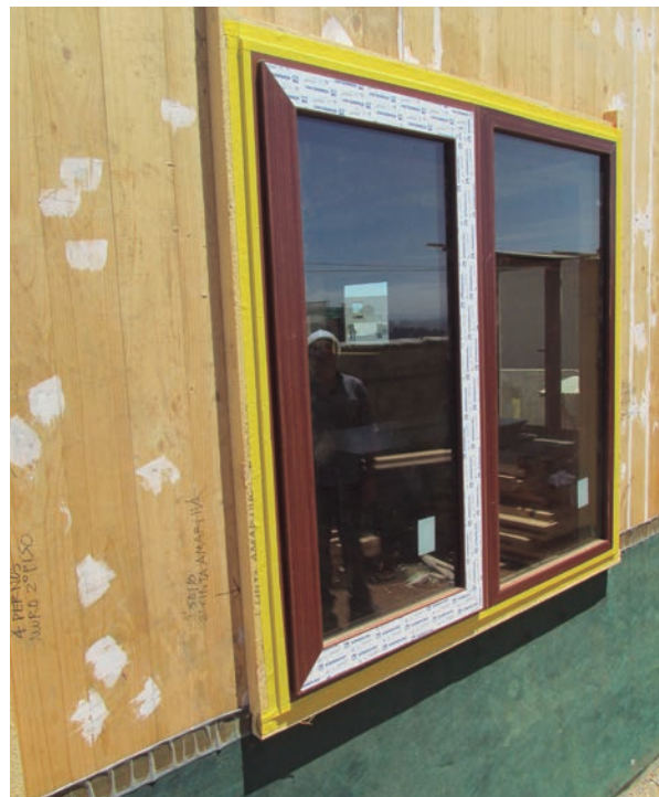
Figura 10.34: Sellos en unión marco-muro, por el exterior
