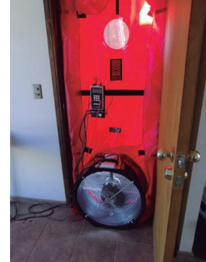
Figura 10.18: Ensayo Blower Door a vivienda tipo Condominio Nuevo Mundo
