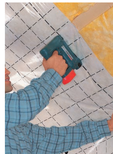
Figura 7.5: Sello de continuidad de membrana resistente al paso del aire mediante cinta mono adhesiva.
