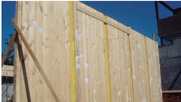
Figura 10.29: Cintas adhesivas sellan las uniones entre los paneles
