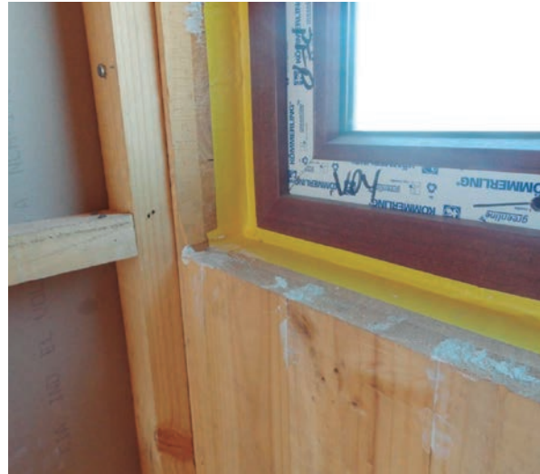
Figura 10.33: Sellos en unión marco-muro, por el interior
