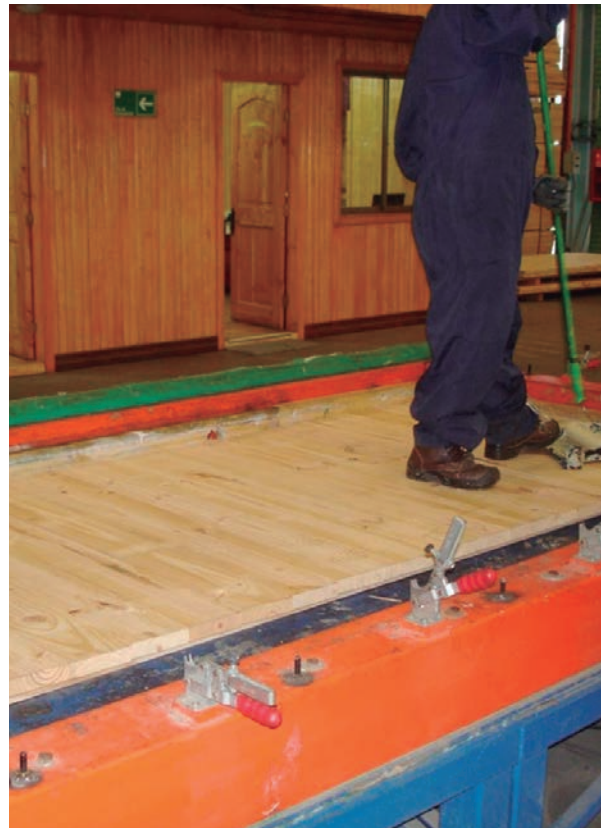
Figura 10.22: Prefabricación de los paneles de CLT
