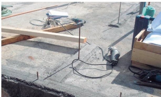
Figura 10.24: Bases de soleras niveladas
