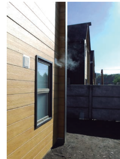
Figura 10.19: Visualización de flujos de aire con humo
