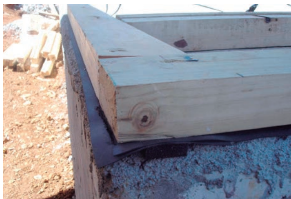
Figura 10.25: sello bajo solera incluye un Compriband (marca Rothoblaas)
