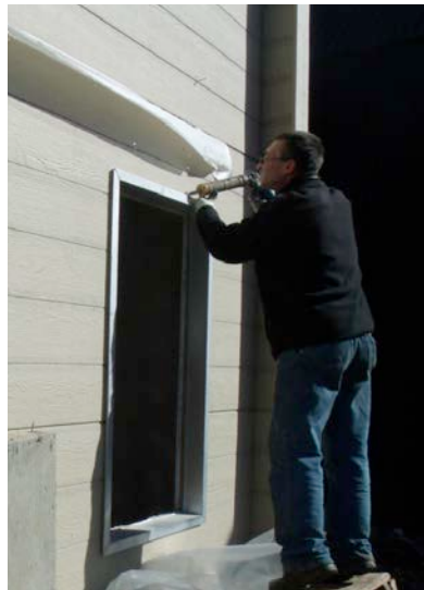
Figura 10.13: Aplicación de sello de silicona en marcos de ventanas
