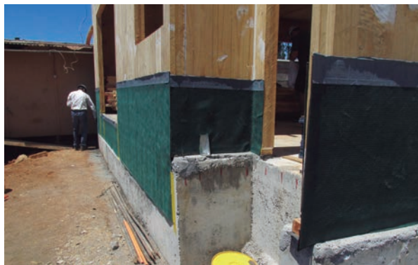
Figura 10.27: Membrana bituminosa de sello autoadhesiva en unión sobrecimiento-panel
