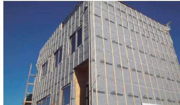
Figura 10.31: Membrana de barrera al viento
