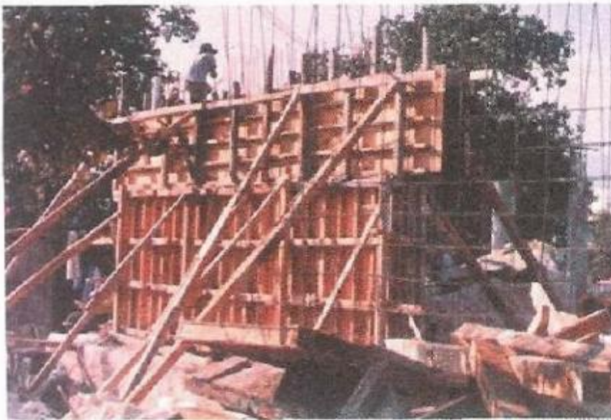
Foto No 1. Cimbrado muro frontal de concreto.
