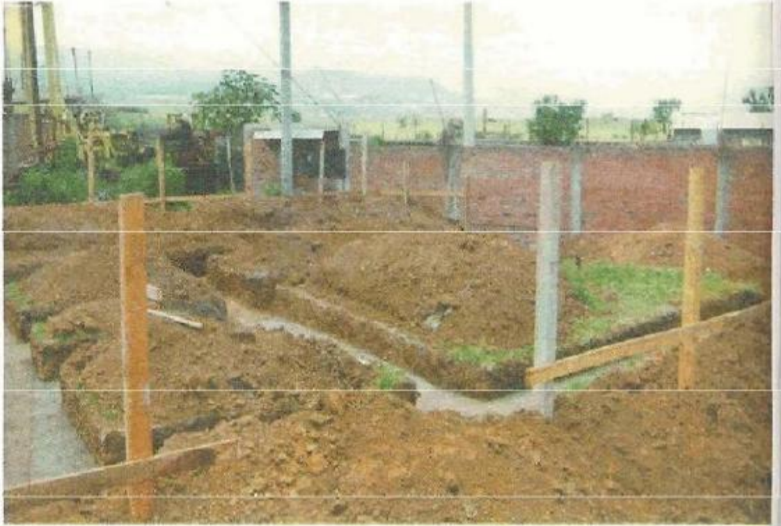
Cualquiera que sea el tipo de cimentación, el trabajo comienza con una excavación
