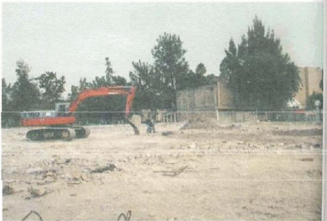
En cambio, la excavación mecánica presenta mayores riesgos, que el Residente deberá tomar en cuenta.
