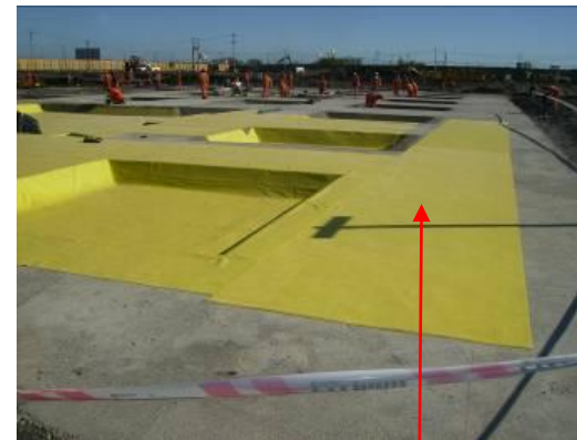
Membrana sobre emplantillado
