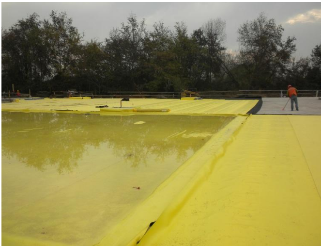
Impermeabilización Movicenter (10.000 m 2 )
