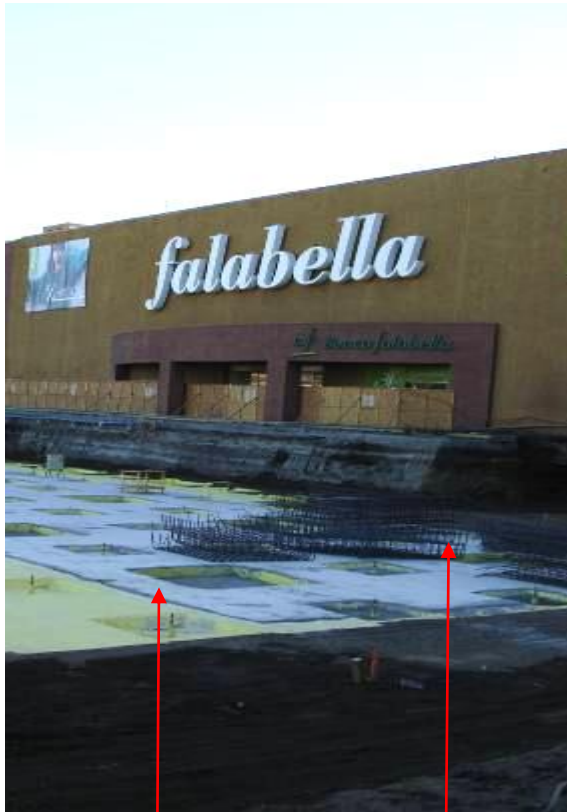
Mortero de protección
