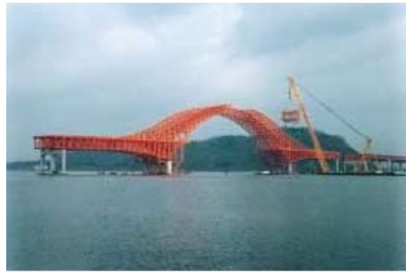
Colocación de la dovela central del arco
