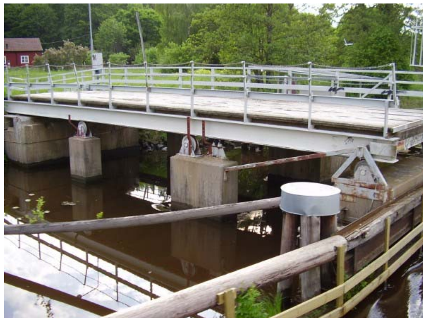
Calzada sobre rodillos del puente retractable en Uppsala
