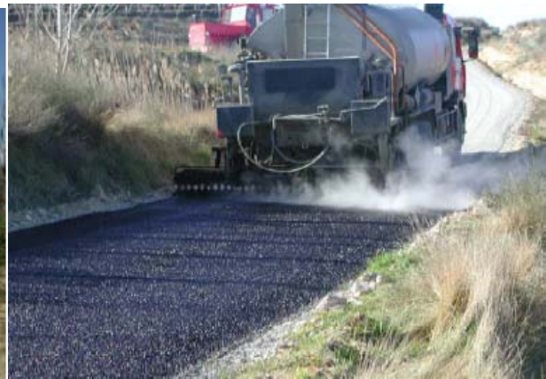
Riego de emulsión
