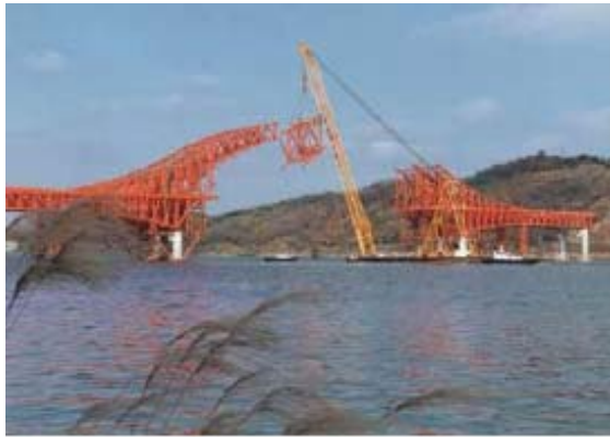
Colocación de dovelas del arco
