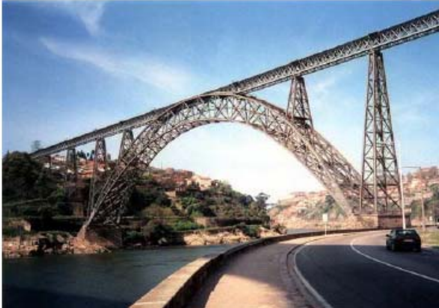
Puente de acero 'María Pía', (Oporto), Gustavo Eiffel, 1887. Longitud del vano central: 160 m.
