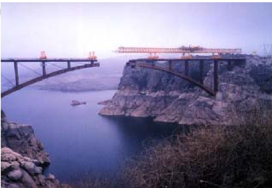
Imagen de los dos voladizos y la viga de lanzamiento de dovelas
