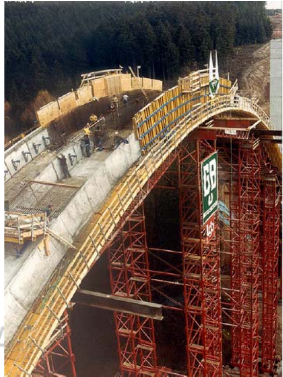
Detalle de sección en cajón del arco
