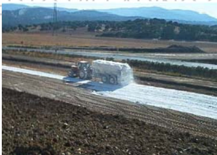
Extendido de la cal por vía seca (tractor con tolva)
