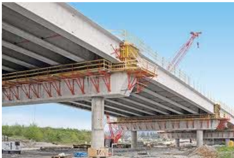
Puente de vigas prefabricadas
