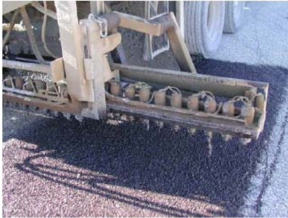
Camión cuba con rampa de riego asfáltico
