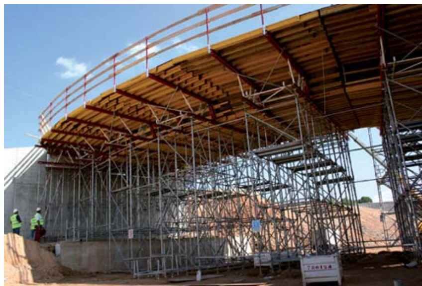
Dos equipos de cimbra y un encofrado
