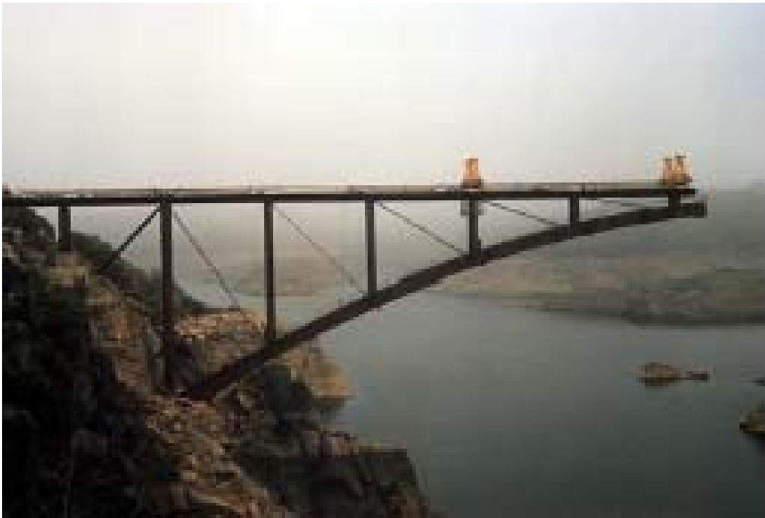
Imagen de medio arco en voladizo con los tirantes a tracción
