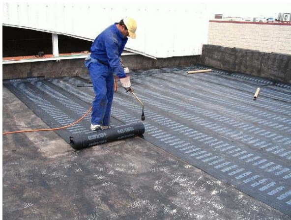
Membrana asfáltica sobre azotea
