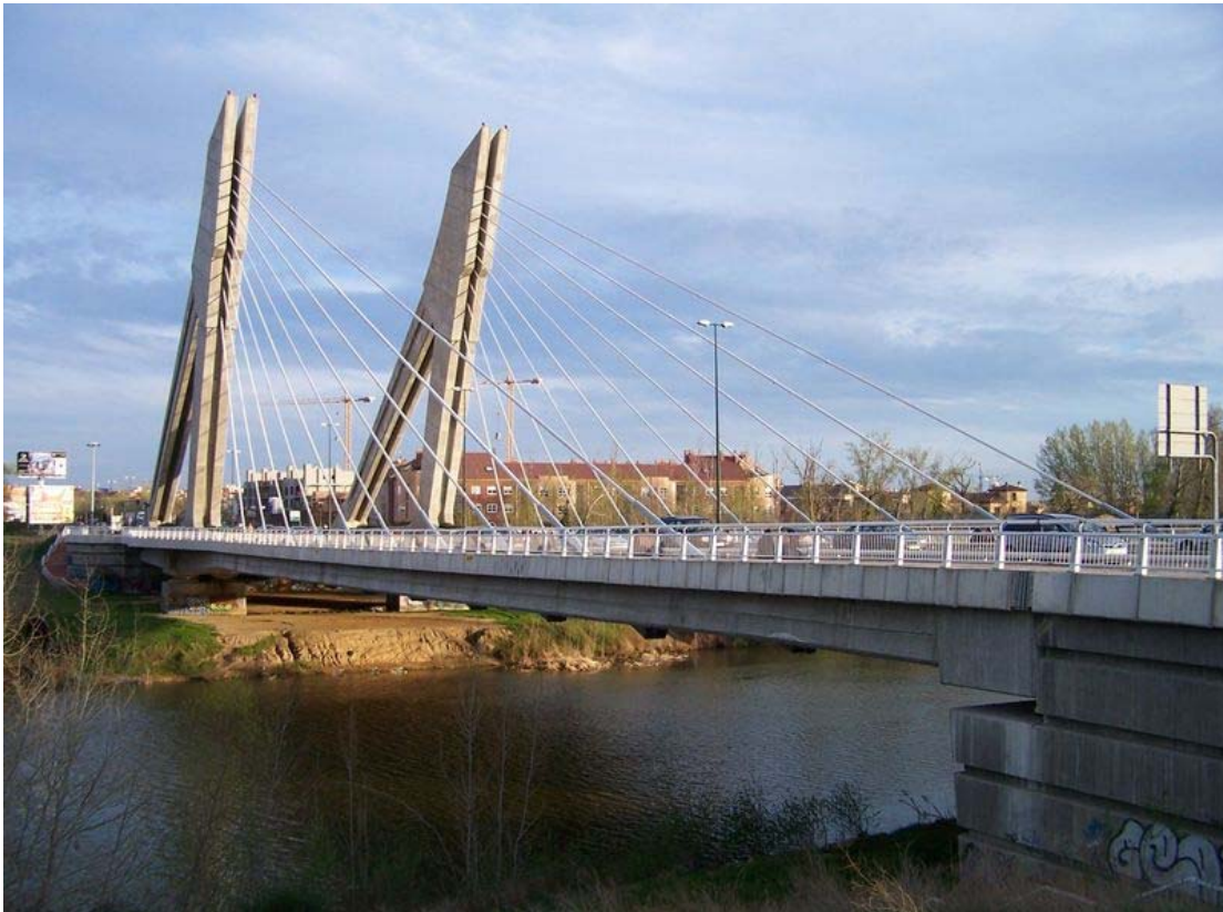
Una sola torre desde donde se atiranta todo el vano principal
