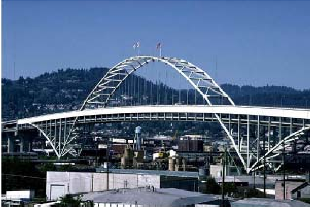
Puente de Fremont, Portland (USA), 1973. Longitud del vano: 383 m.
