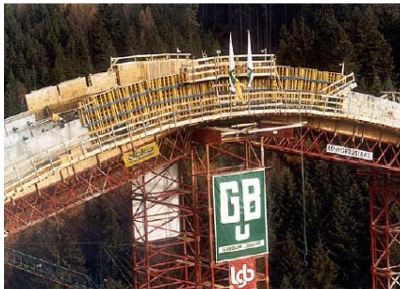
Detalle de cimbra y encofrados
