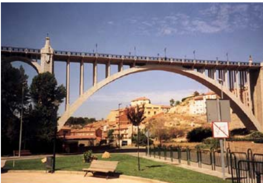
Viaducto de hormigón de Teruel
