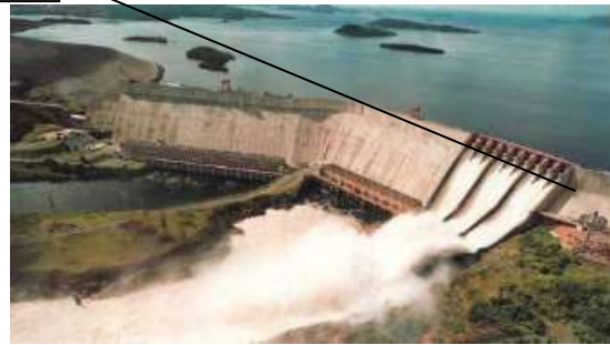
Aliviadero Independiente de la presa
