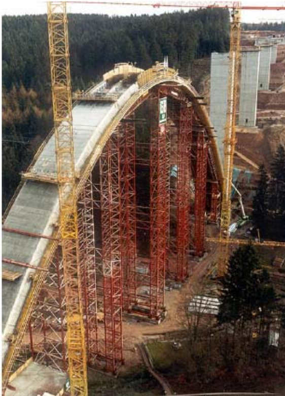
Vista general de cimbra y andamiaje
