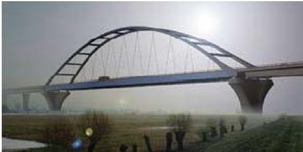
Puente de Tangermünde sobre el Elba, (Alemania), F. Leonhardt. Longitud del vano: 185 m.
