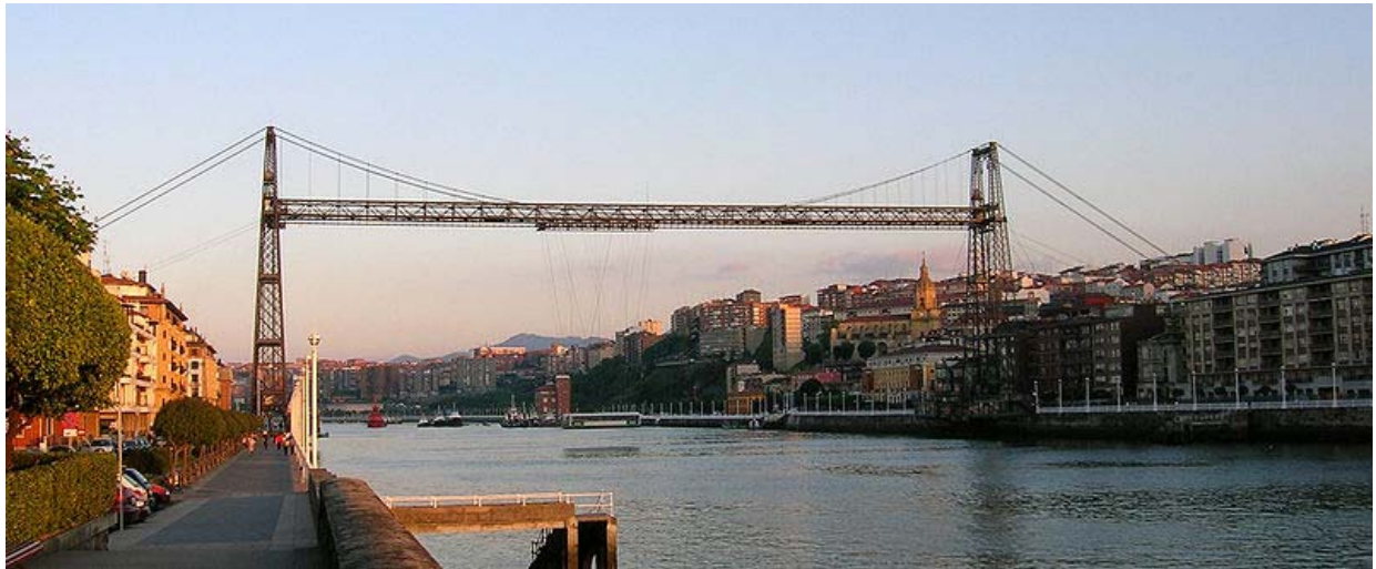
Puente de Vizcaya
