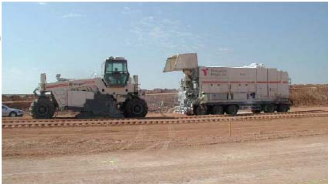
Equipo de mezclado y estabilización (vía húmeda)
