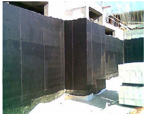
Impermeabilización muro con pintura asfáltica
