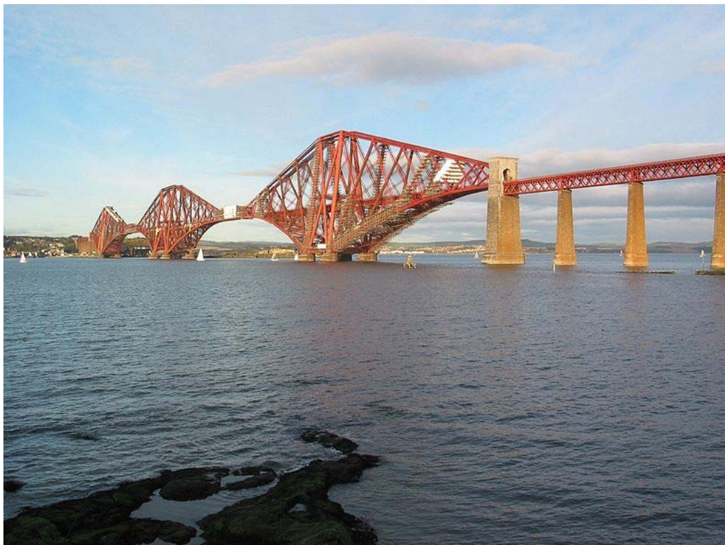
El Puente de Forth, es un puente en ménsula para ferrocarril que atraviesa el Fiordo de Forth, en el este de Escocia 14 km del centro de Edimburgo
