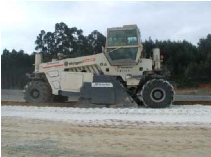
Equipo de mezcla del suelo con la cal (estabilizador)
