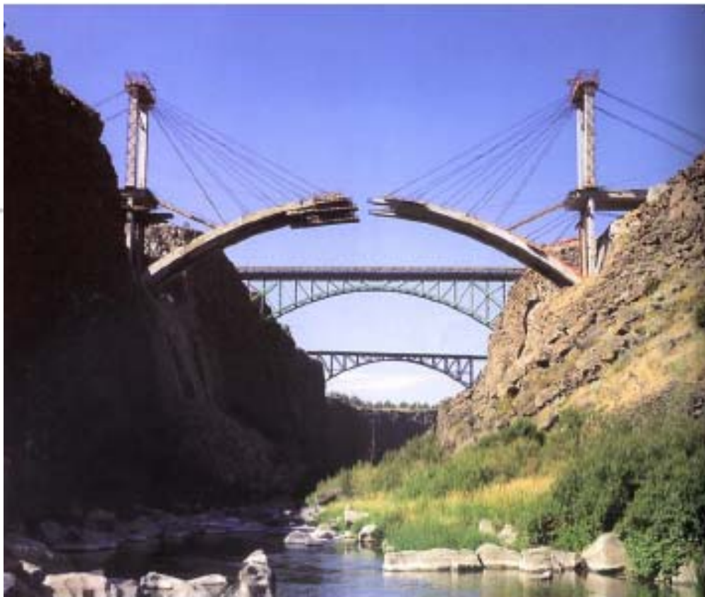
Imagen del arco durante la construcción
