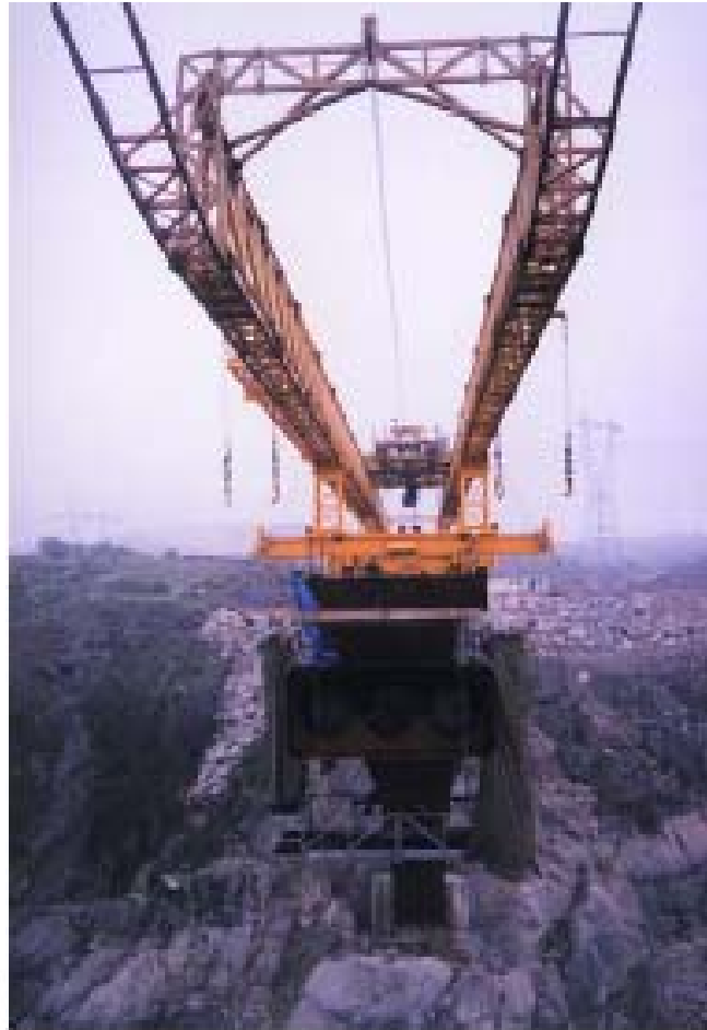
Lanzamiento y colocación de dovela del arco
