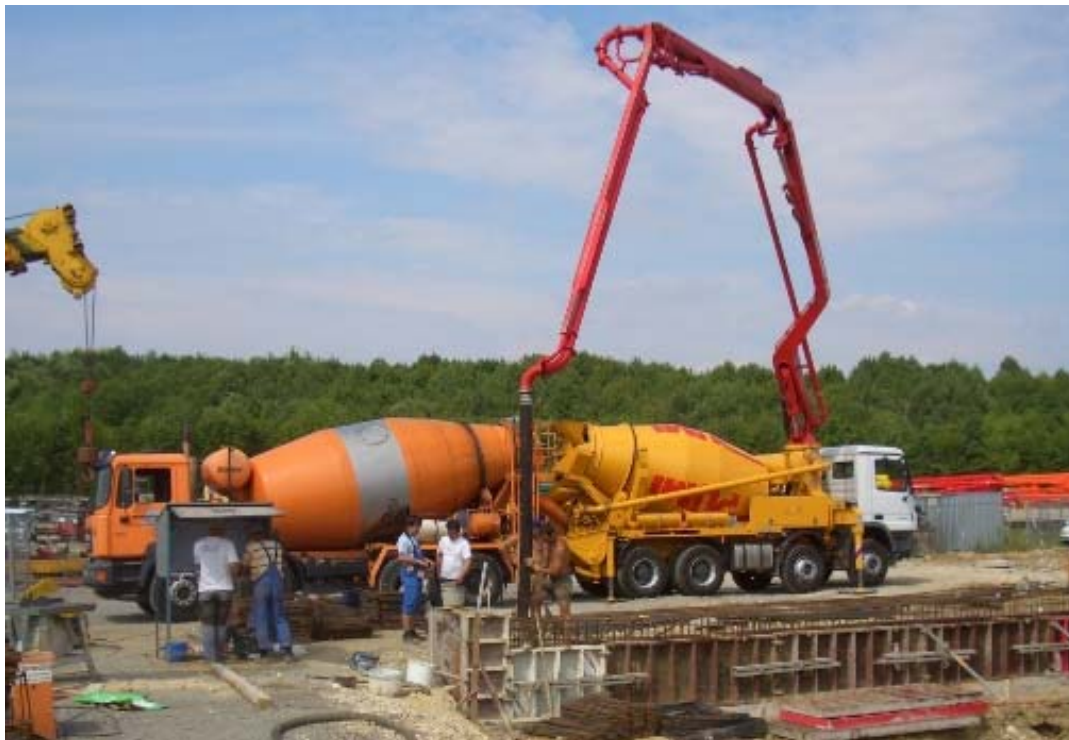
Camión bomba de hormigón
