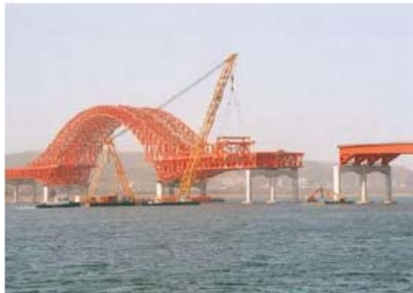
Construcción de vanos de aproximación
