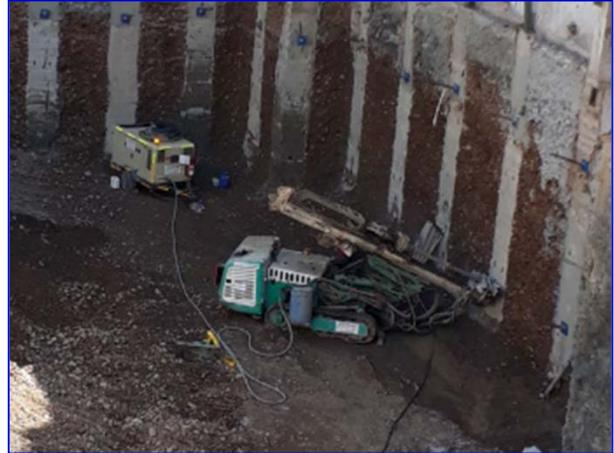
Foto 11 – Perforación anclajes con máquina de anclajes
