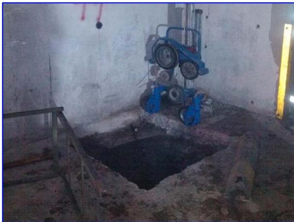
Foto 4 – Corte de losa para pila de socialzado
