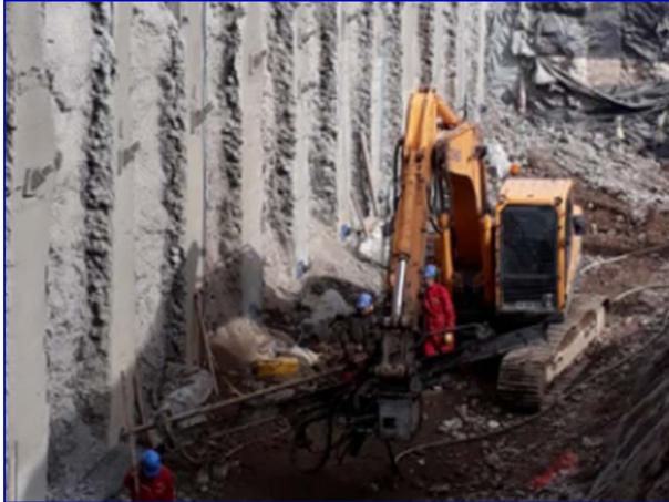
Foto 10 – Perforación anclajes con máquina excavadora
