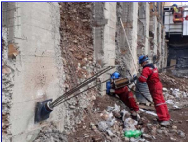
Foto 11 – Tensado de anclajes
