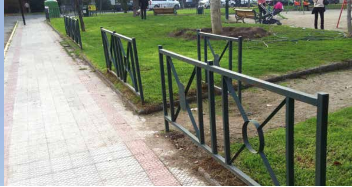
BARANDAS DE METAL, COMUNA DE ÑUÑO A, SANTIAGO
