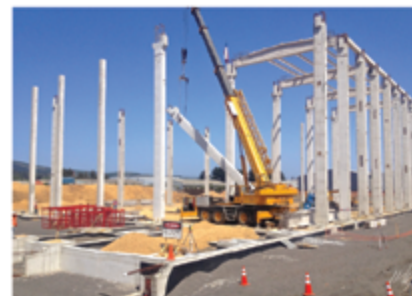
04 Montaje Pilares Híbridos.
