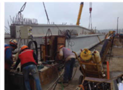
03 Desmolde Vigas Pretensadas
