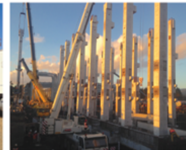
06 Montaje Pilares 26 mts. / 59 Ton.
