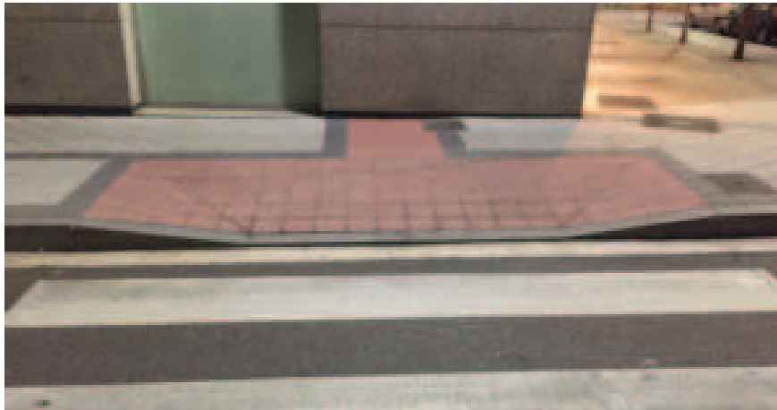
Encaminamiento direccional hasta fachada y baldosas de advertencia en diferentes colores.
