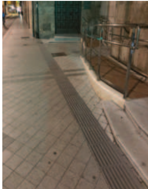
Encaminamientos direccionales en zona sin línea de fachada.
