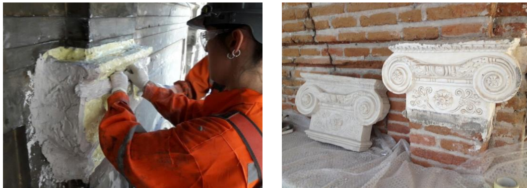
Imagen 20: Castro, F. 2017. Proceso de molde in situ y retoque de capitel jónico ORE 3. Fotografía. Archivo personal.
