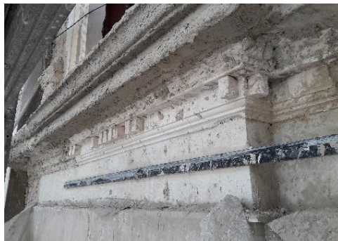
Imagen 38: Castro, F. 2017. Estucado de cornisa y ornamentos ORE 5 decapados. Fotografías. Archivo personal.
