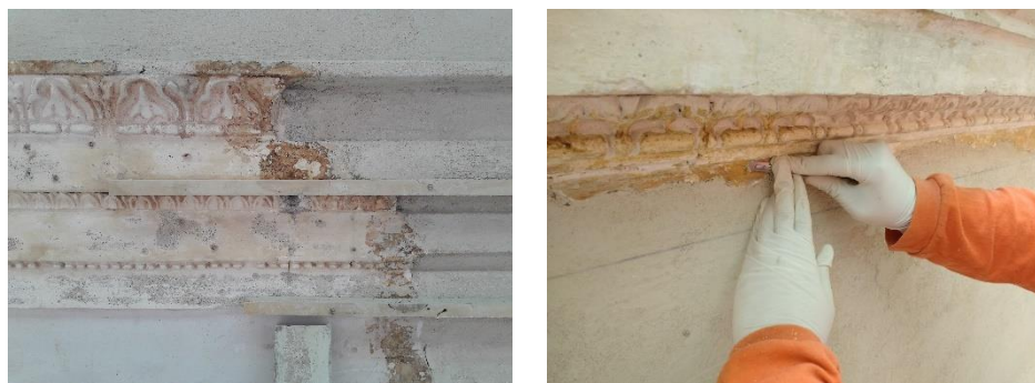
Imagen 39: Castro, F. 2017. Retiro de látex en arquitrabe y ORE 21. Fotografías. Archivo personal.
