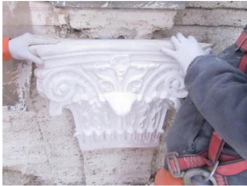
Imagen 22: Castro, F. 2017. Proceso de instalación de capitel, fachada San Martín, etapa 1. Fotografía. Archivo personal.
