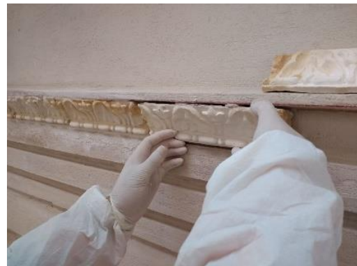
Imagen 23: Castro, F. 2017. Proceso de instalación de ORE 15, fachada Huérfanos, etapa 3. Fotografía. Archivo personal.
