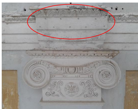
Imagen 48: Castro, F. 2017.Consolidación de architrabe y ORE 25, ejemplo de consolidación ideal. Fotografía. Archivo personal.
