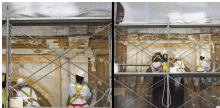
Imagen 6: Dirección de Arquitectura, MOP. 2014. Proceso de limpieza en muro de muestra, Fachada San Martín. Fotografía. Recuperado de: (Públicas, 2014, pág. 218)
