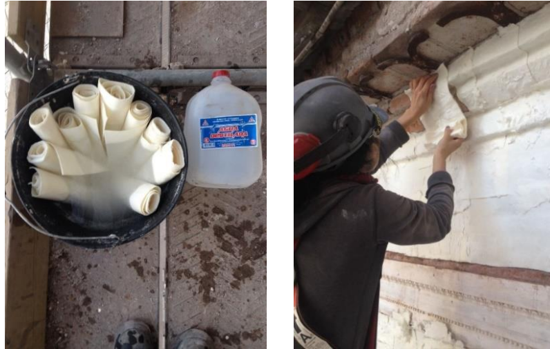
Imagen 15: Castro, F. 2017. Proceso de desalación, celulosa remojada en agua destilada y aplicación de celulosa remojada en el muro. Fotografías. Archivo personal.
