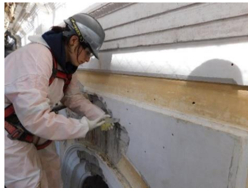
Imagen 19: KALAM. 2017. Proceso de consolidación, inyección de solución de Acril33 más agua destilada. Fotografía. Recuperado de: Restauración Palacio Pereira y reposición edificios CMN y DIBAM.
