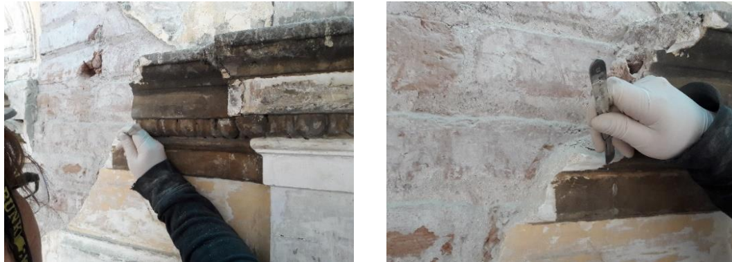
Imagen 13: Castro, F. 2017. Limpieza mecánica con bisturí. Fachada San Martín, etapa 1. Fotografía. Archivo personal.
