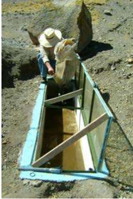
Filtro de bioarena. Proyecto Allimpaq Fuente: Album soluciones practicas, Proyecto Allimpaq ( https://www.flickr.com/photos/soluciones-practicas/3897882658 )
