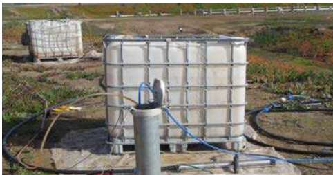
Proceso de remediación de un acuífero contaminado con hidrocarburos mediante la utilización de skimmers, que extraen selectivamente el hidrocarburo sobrenadante.
