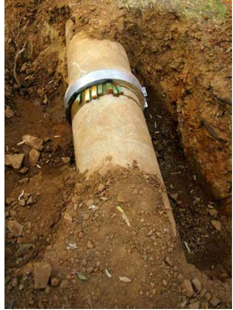
Conducción de agua en reparación. Fuente: ©Bidegee (Wikimedia Commons)
