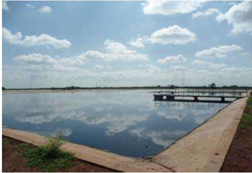
Laguna facultativa en Ruai, Kenya Fuente: Sustainable Sanitation Alliance ( https://commons.wikimedia.org/wiki/File:Facultative_pond_(6898410678).jpg )
