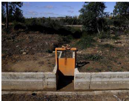
Inauguración revestimiento canal de riego en Cauquenes, Fuente: Ministerio de Agricultura de Chile ( https://www.flickr.com/photos/minagri/34024115082 )
