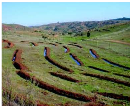
Funcionamiento de las zanjas de infiltración después de la caída de lluvias. Fuente U. de Talca, 2004
