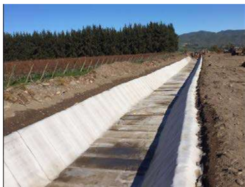
Manta hormigón en canal de riego.
