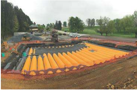
Producto sc-740 siendo instalado. Fuente:Stormtech ( https://www.stormtech.com/product/sc740 )
