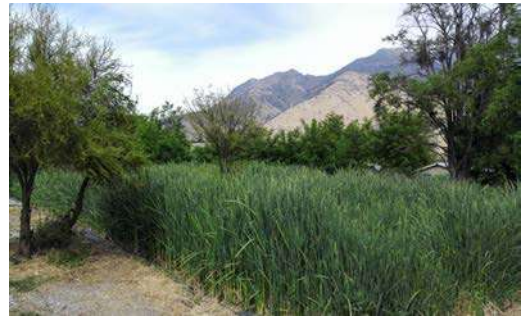
Humedal subsuperficial, tecnología Biotreat instalado en Til Til. Fuente: Fundación Chile, 2017.
