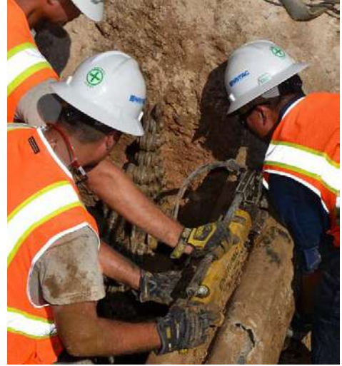
Reparación tuberías. Fuente: 624th Civil Engineering Squadron ( www.624rsg.afrc.af.mil )
