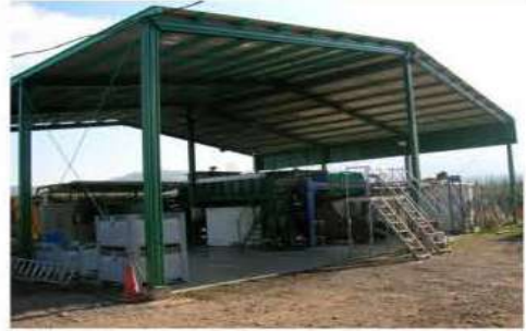
Planta de tratamiento fisicoquímico de Viña San Pedro, Planta Molina. Capacidad de tratamiento 900 (m 3 /día). Fuente: Fundación Chile 2010
