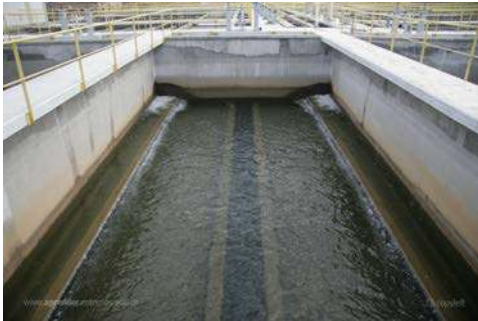
Filtro arena en río Paraná.
