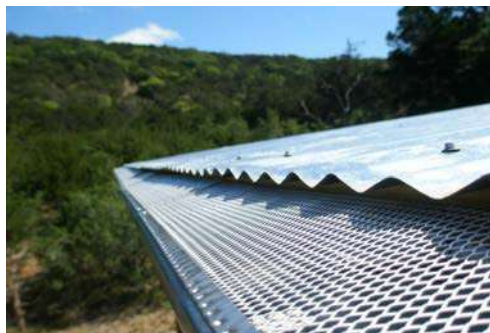
Vista de un techo acondicionado para recolectar agua lluvia. Fuente: SaveGreenery ( http://www.savegreenery.co.in/wp-content/uploads/2018/05/177546bdd2c202638fc0ae845b3d8b4b.jpg )
