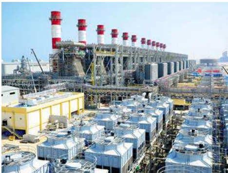
Desaladora de Al Jubail.
