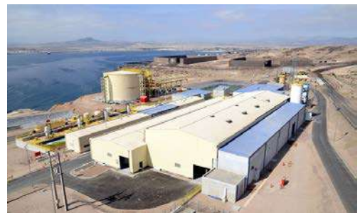
Planta desalinizadora minera Manto Verde. Fuente: Revista Minería Chilena ( http://www.mch.cl/2017/01/25/candelaria-evalua-positivamente-planta-desalinizadora-tras-cuatro-anos-operaciones/ )
