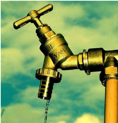
Fuga de agua.
