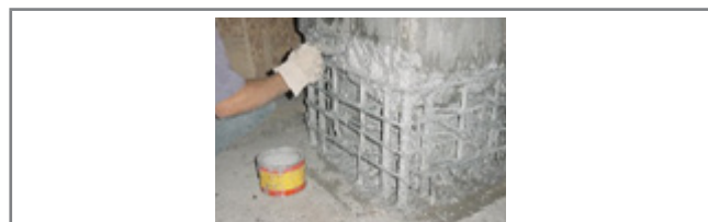
Aplicación de puente de adherencia en pilares de hormigón armado con Colma Fix® 32
