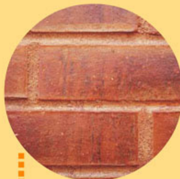
Ladrillo bien protegido
