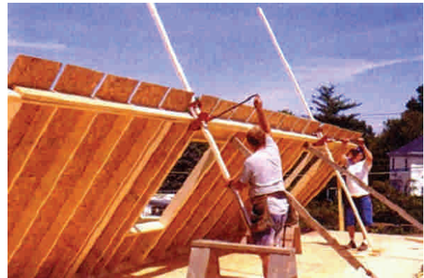
Figura 10 - 77: Etapa de montaje de muros prefabricados en obra directamente sobre la plataforma.
