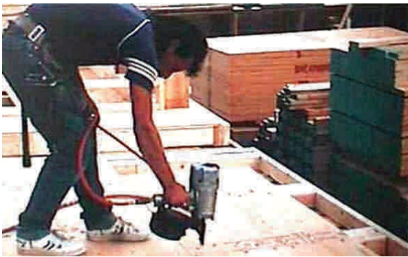
Figura 10 - 33: Fijación de contrachapado estructural al entramado por medio de clavadoras de aire comprimido.
