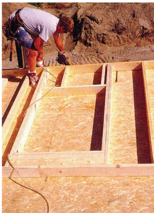
Figura 10 - 27: La calidad de la madera utilizada es esencial para la prefabricación de los entramados verticales, ya que de ello depende fundamentalmente la durabilidad y estabilidad de los elementos en servicio.
