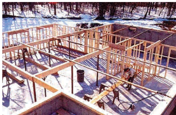
Figura 10 - 31: Tabiques ya estructurados en el primer piso de una vivienda. Durante el proceso de clavado y fijación, es primordial el control geométrico como: alineación, verticalidad (plomada), anchos, largos y espesores con respecto al diseño planimétrico y altimétrico de la vivienda.
