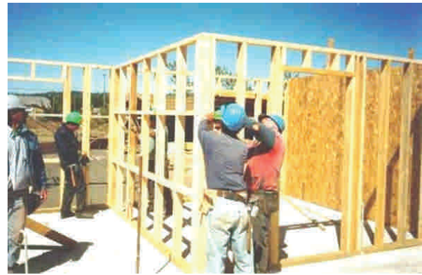
Figura 10 - 73c: El elemento finalmente es levantado, anclado y fijado sobre su eje de ubicación de forma rápida y expedita.
