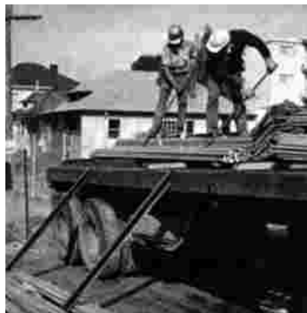
Descarga manual del acero desde camión.
