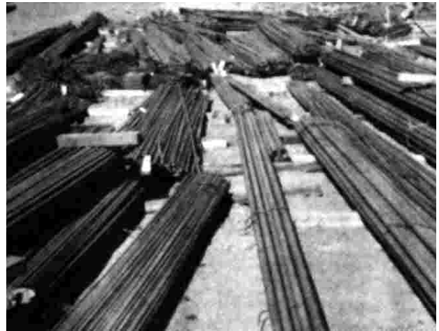
Almacenamiento de las barras sobre cuarterones
