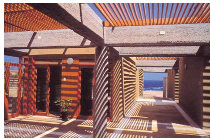
Figura III.2.1.7.2: Casa Retiro Fundación Alonso Ovalle. Colegio San Luis, Antofagasta (Zona Norte Litoral). 1991. Arquitecta Glenda Kapstein. Fotografía gentileza Arq. José Guerra.
